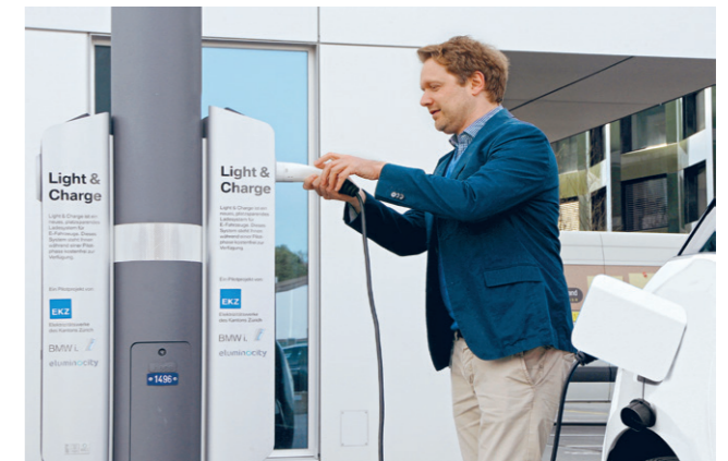
Abb. 5: Kandelaber-Ladestationen sind an einem Lichtmast fixiert (Quelle: EKZ).
