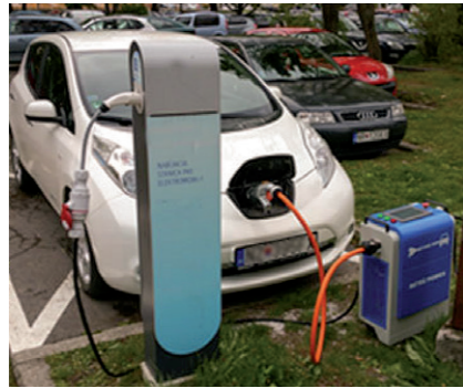
Abb. 8: Die volle Leistung einer AC-Ladestation (22 kW) kann nur ausgenutzt werden, wenn ein mobiler AC/DC Konverter zur Verfügung steht.
