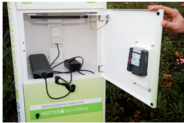
Abb. 26: Ladestation für E-Bikes mit Raum für Ladegerät und Helm.
