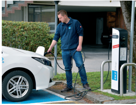
Abb. 35: Ladestation für normales/beschleunigtes Laden (Quelle: EKZ Eltop).
