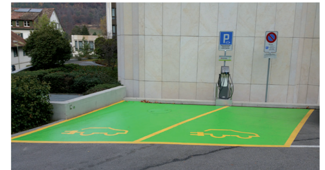
Abb. 34: Beispiel der horizontalen und vertikalen Beschilderung für einen Parkplatz bzw. Ladeplatz, der für das Laden von eFahrzeugen reserviert ist. Weitere Angaben müssen je nach Art des Parkplatzes angepasst werden.
