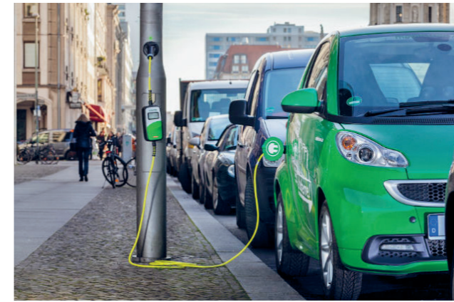
Abb. 73: Zähler im Kabel integriert (Ubitricity).
