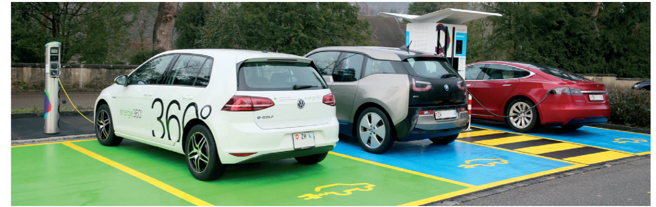
Abb. 84: Öffentlicher Parkplatz Schloss Laufen (Quelle: Energie 360°).
